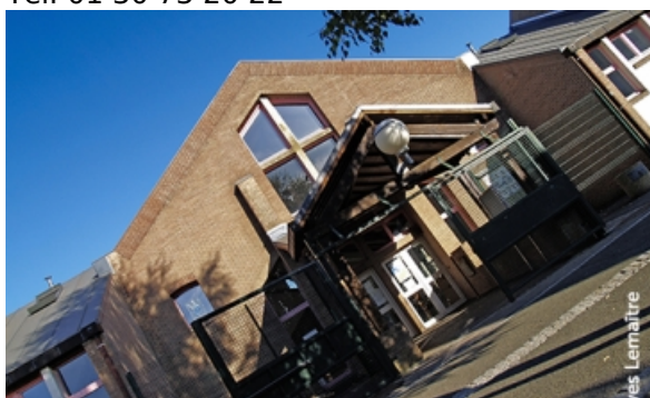
École des Hauts-Toupets 4-6 chemin des Hauts Toupets Tél. 01 30 73 26 19
